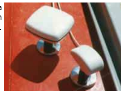
Fig 3: ubicación y detalle del sensor de flujo por celda de carga, acoplado en la parte superior de la noria
