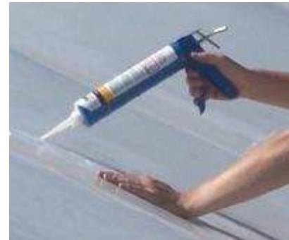
Figura 7: Sellado mediante pegamento siliconado en los bordes de la cinta.
